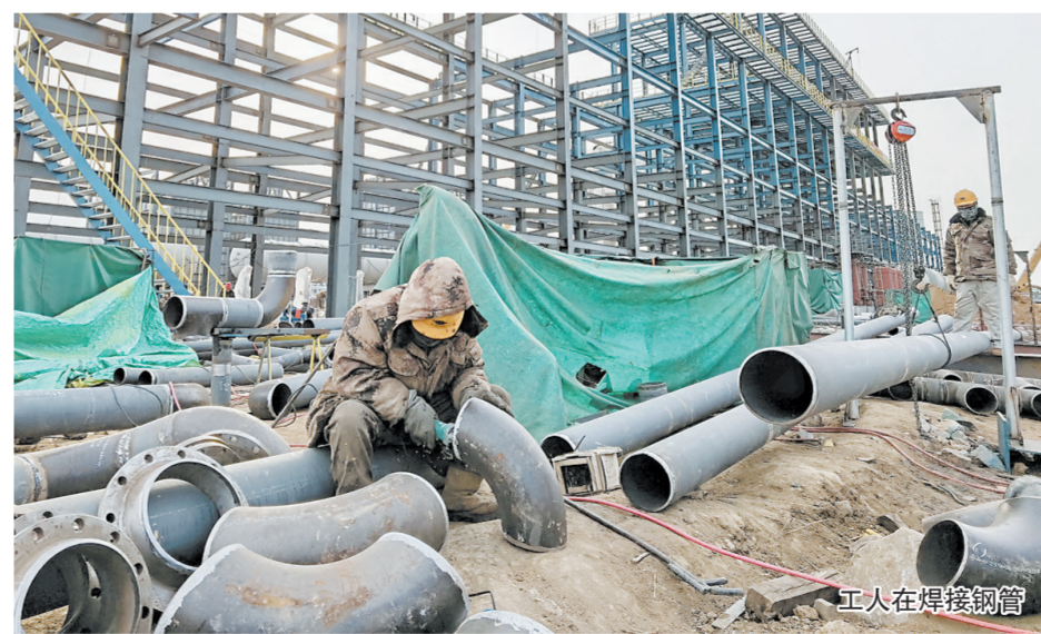
工人在焊接钢管
