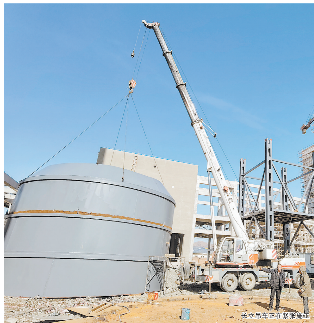
长立吊车正在紧张施工
