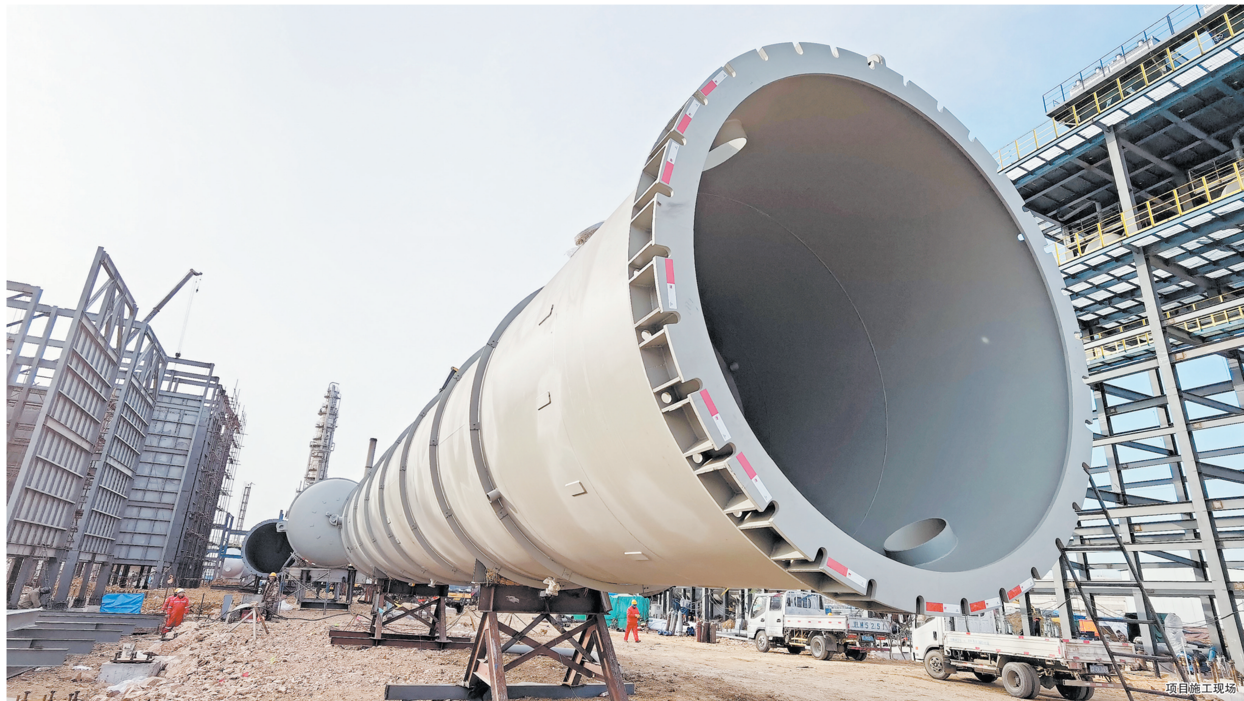
项目施工现场
