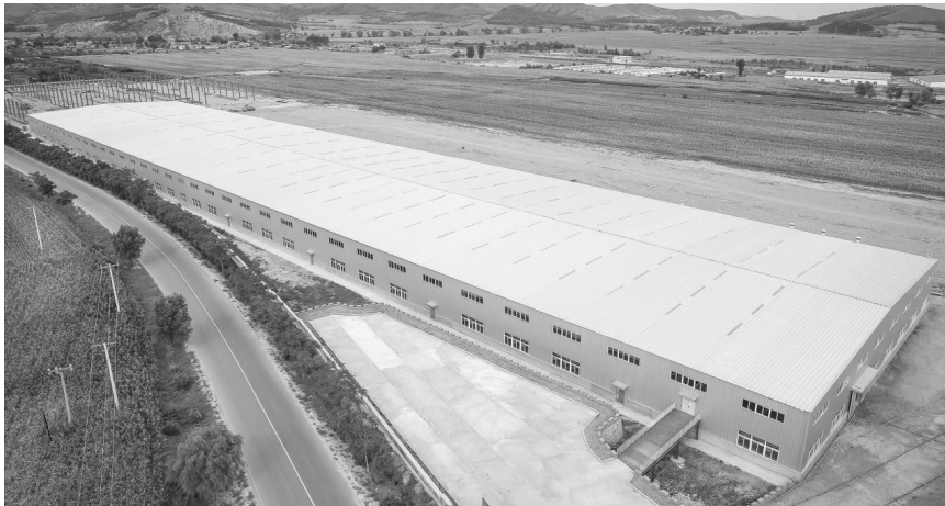
2014年，成功承接了首个10万平方米企业园区建设工程。
