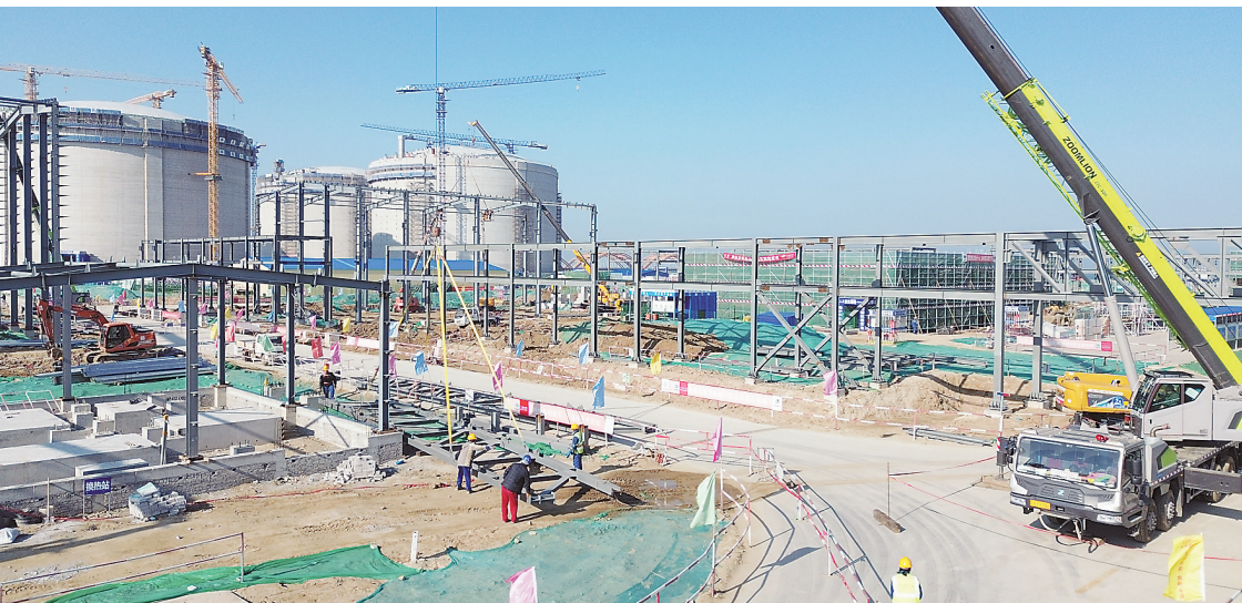
图为中交营口LNG接收站项目冬季施工现场。
