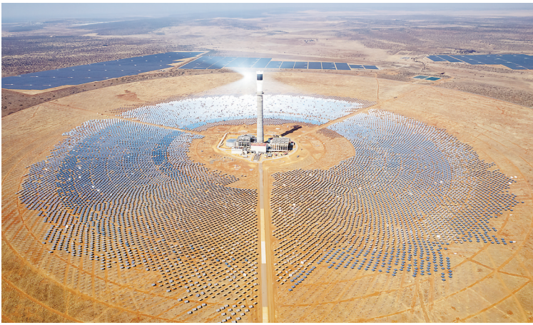
这是2024年8月20日在南非北开普省拍摄的由中国电建集团山东电建三公司承建的南非红石100兆瓦塔式熔盐光热电站项目（无人机照片）。该项目是撒哈拉以南非洲首个塔式熔盐光热电站项目，也是南非最大可再生能源投资项目之一。
