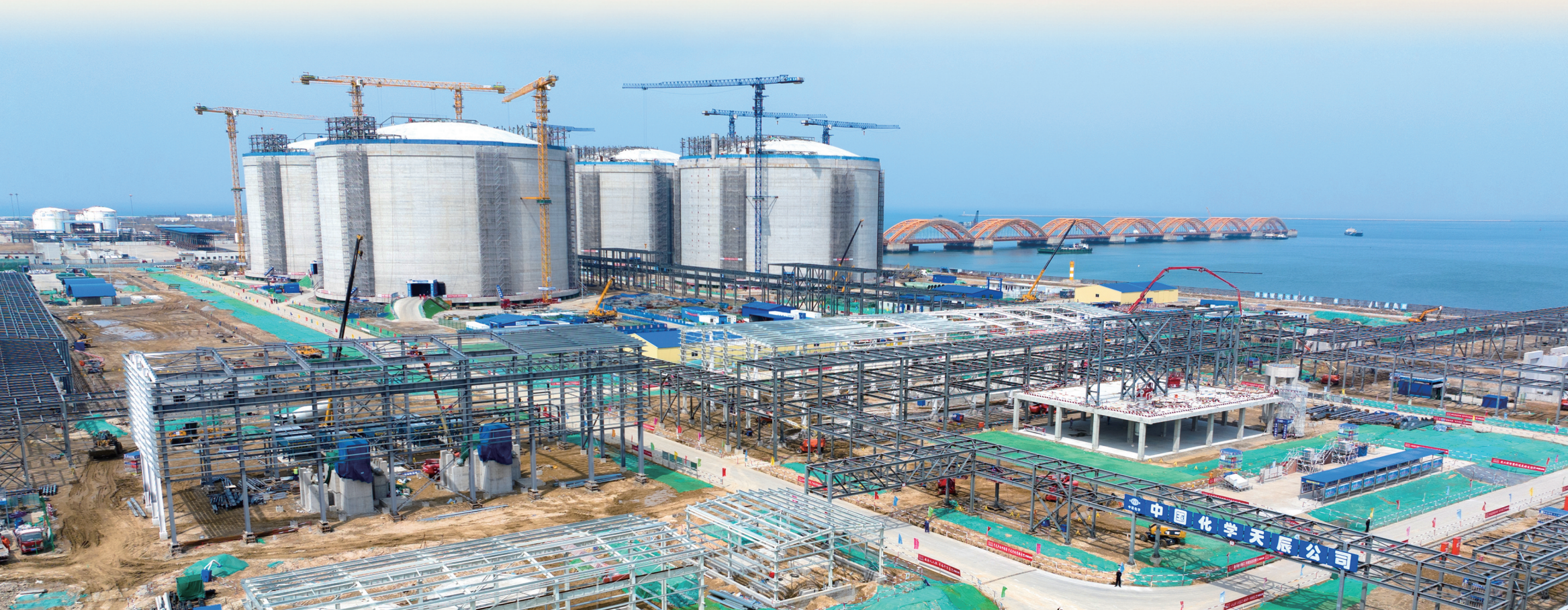
▲4月27日，营口LNG接收站项目4台20万立方米储罐内罐首圈壁板焊接工作全面告捷。
