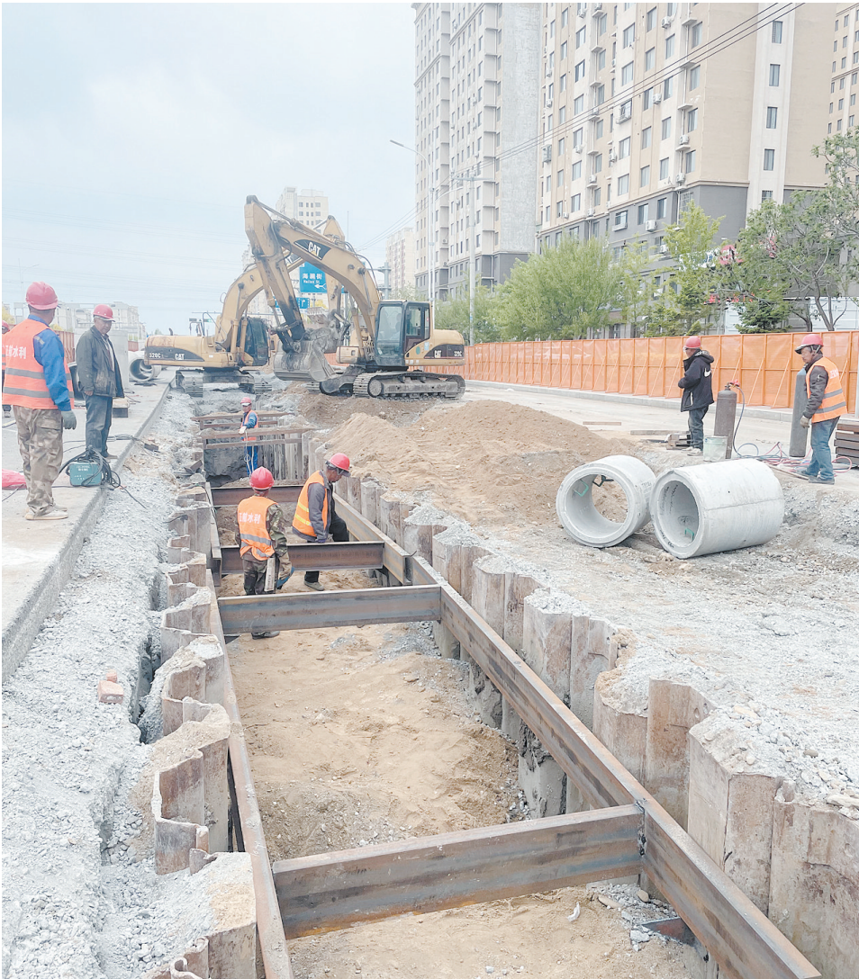
新华路封闭路段施工现场。
