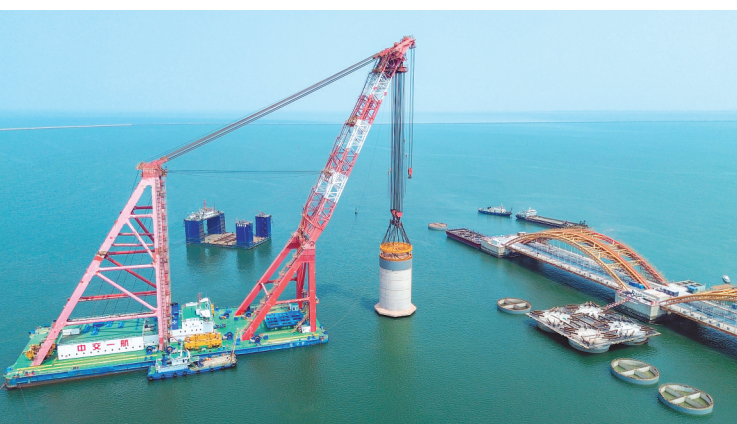
仙人岛港区2号原油码头。 本报记者 张宝全 摄 域管线为2根内径900毫米原油管线，陆域钢结构管廊约为7.58千米。该工程共需预制12座沉箱，其中包括9座圆沉箱，3座方沉箱，其
