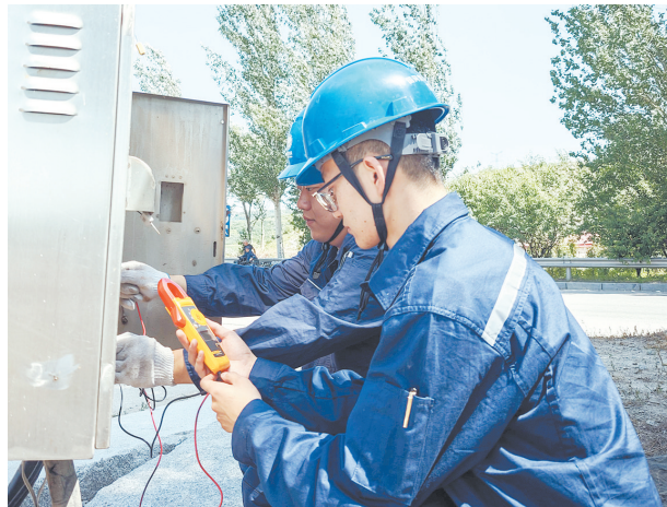
工作人员对设备进行检查。
