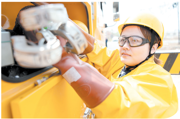
在带电作业现场搬运器具。
