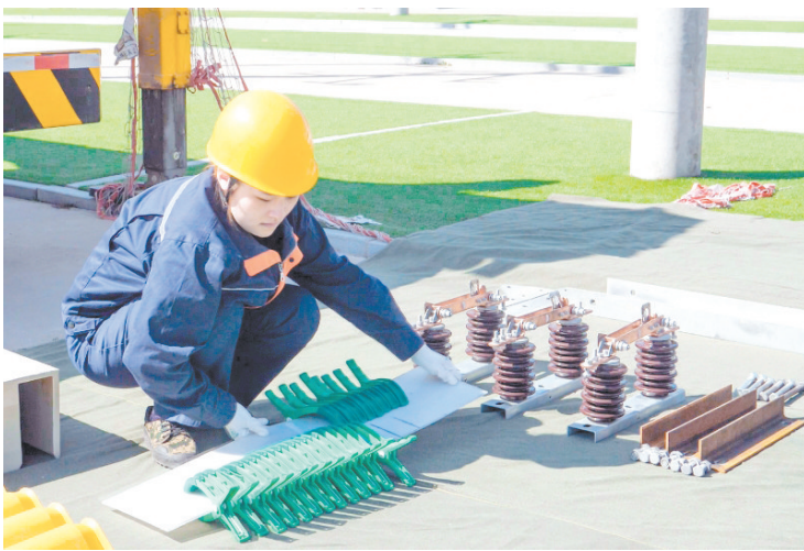
进行器具绝缘检测。
