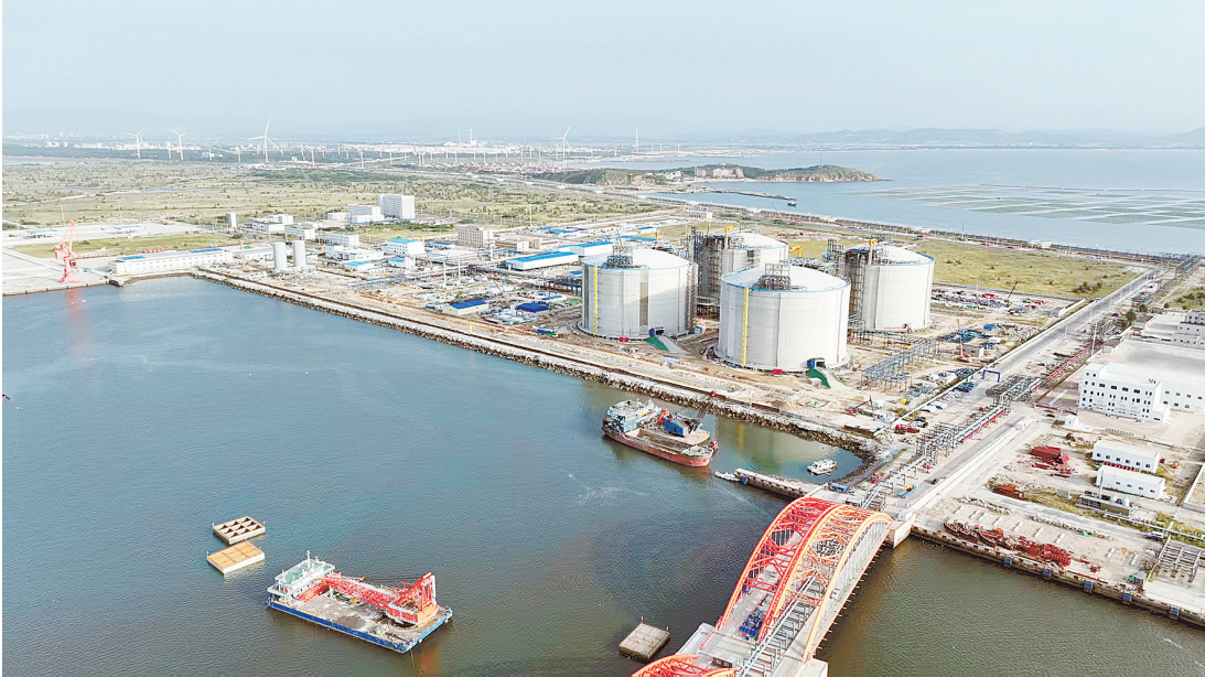
营口仙人岛经济开发区营口LNG接收站项目周边鸟瞰，画面右侧大罐为4台20万立方米LNG储罐。 本报记者 张宝全 摄
