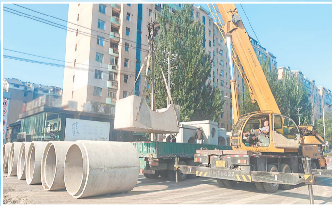
增大排水管网口径，延长管网使用寿命。
