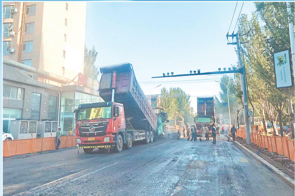
倒排工时，抢工期，完成排水管网改造最后一公里。
