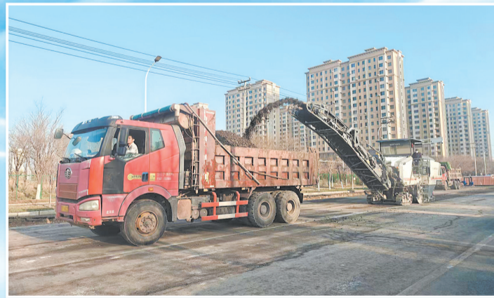
排水管网改造完成一处，路面恢复跟一处。
