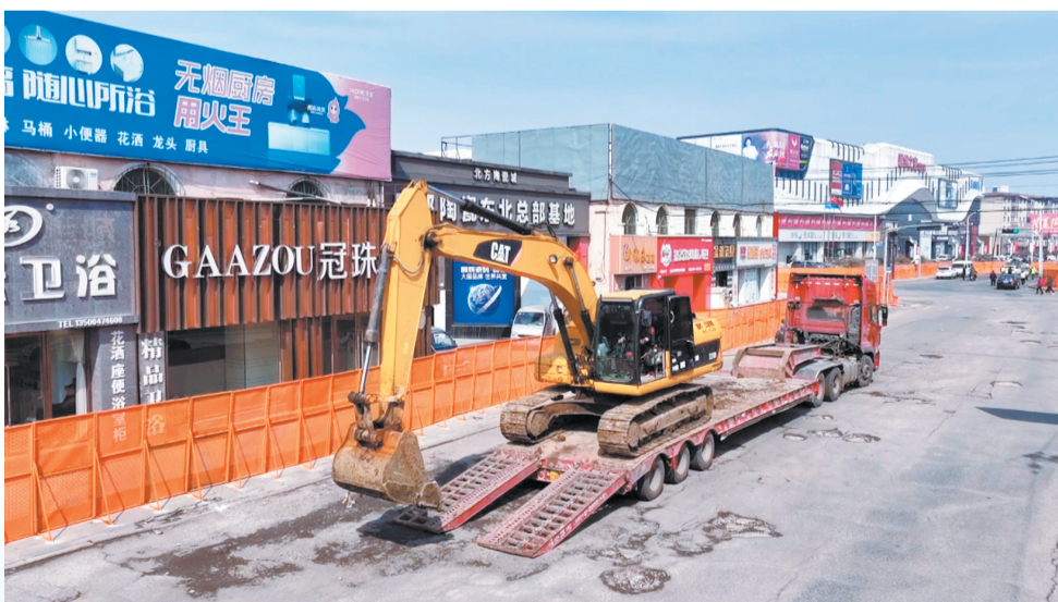
地下排水管网改造工程开工。
