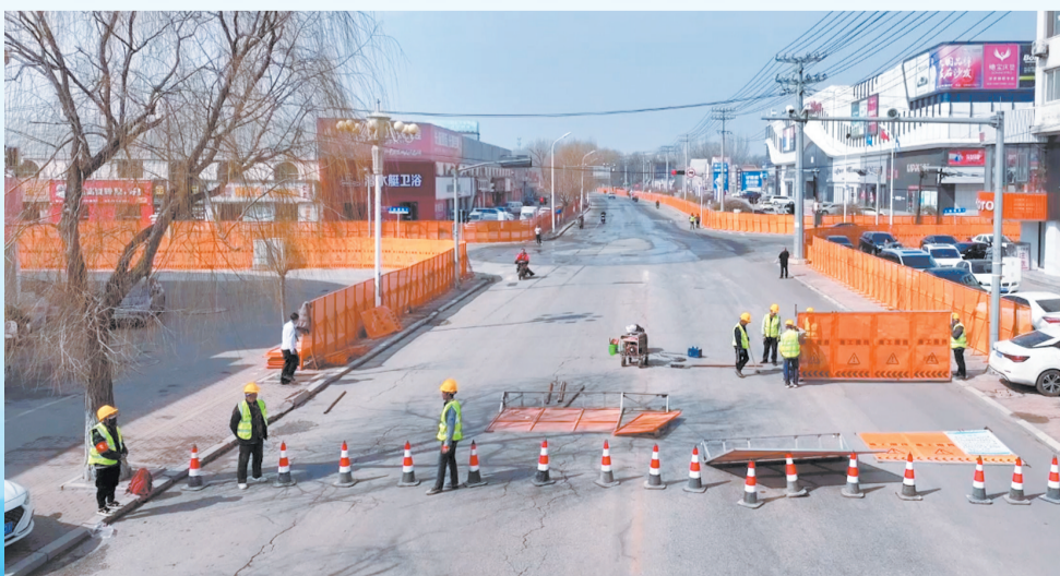
科学安排道路封闭绕行。
