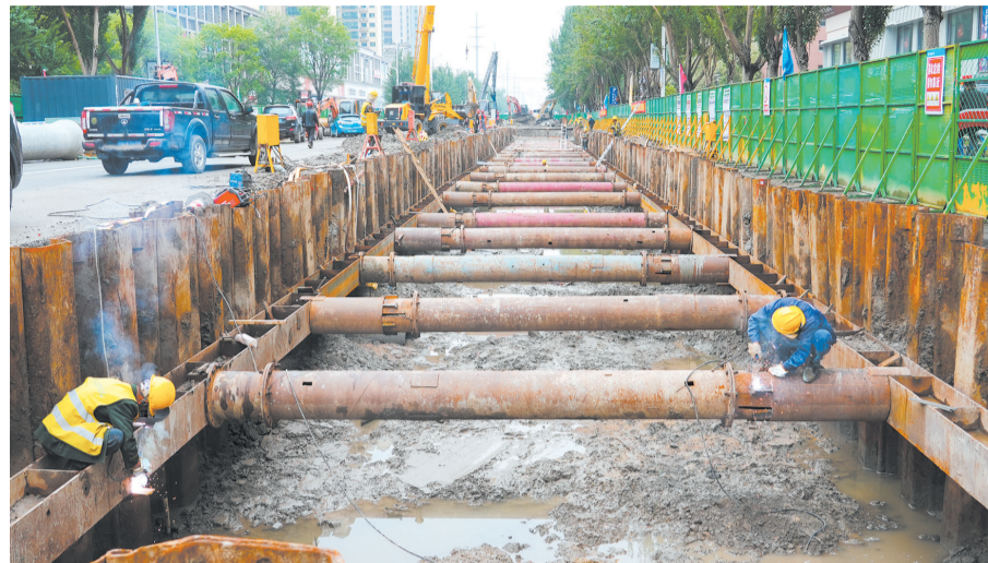
排水管网改造施工现场。
